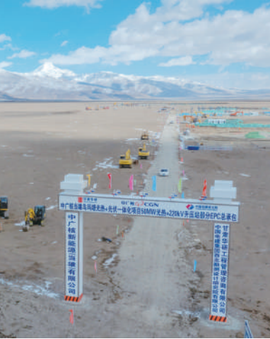
这是中广核西藏当雄乌玛塘50兆瓦光伏电站破土动工现场。4月6日上午，中广核西藏当雄乌玛塘“光热+光伏”一体化项目中的50兆瓦光伏电站在拉萨市当雄县乌玛塘乡正式开工建设。据中广核光热技术型首席专家尹航介绍，该项目场址海拔4550米，是目前全球海拔最高的槽式光热电站。 新华社记者 丁增尼达 摄
